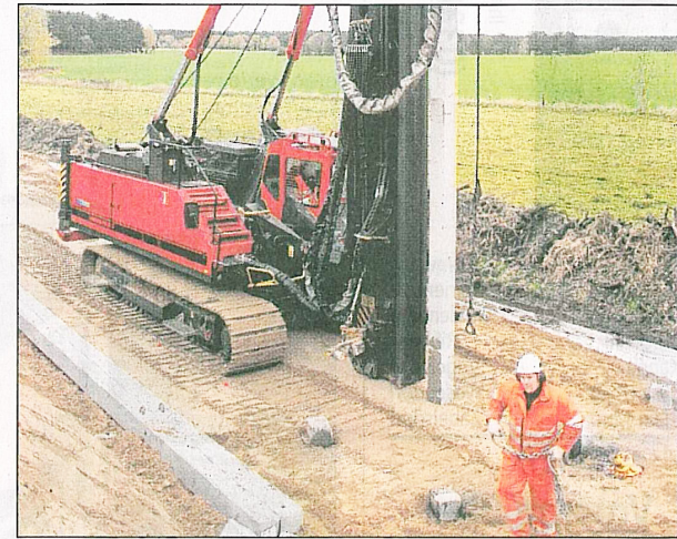
Bei sechs Tonnen Aufprall entsteht sogar Feuer: Diese Ramme versenkt pro Tag 35 der Pfähle. Sechs davon sind derzeit im Einsatz.
