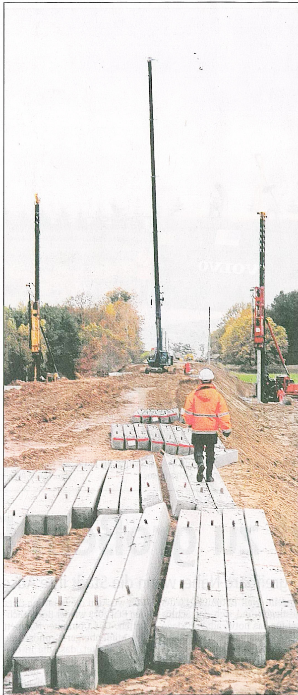
Besuch auf der Großbaustelle: Mehr als 7 500 dieser Stahlbetonpfähle werden in drei Mooren versenkt. Fotos (3): Daniel Dzienian
